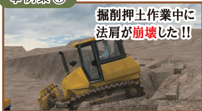
事例集① 土地改良工事編 「肩崩壊によるフルドーザーの転落」より
