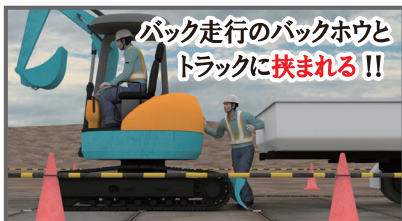
事例集① 土木工事編 「バックホウとトラックによる挟まれ」より
