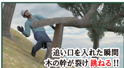
事例集① 治山林道工事編 「伐木作業中に裂けた木の幹が激突」より
